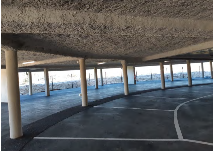
Figure 3 : Vue du parking
