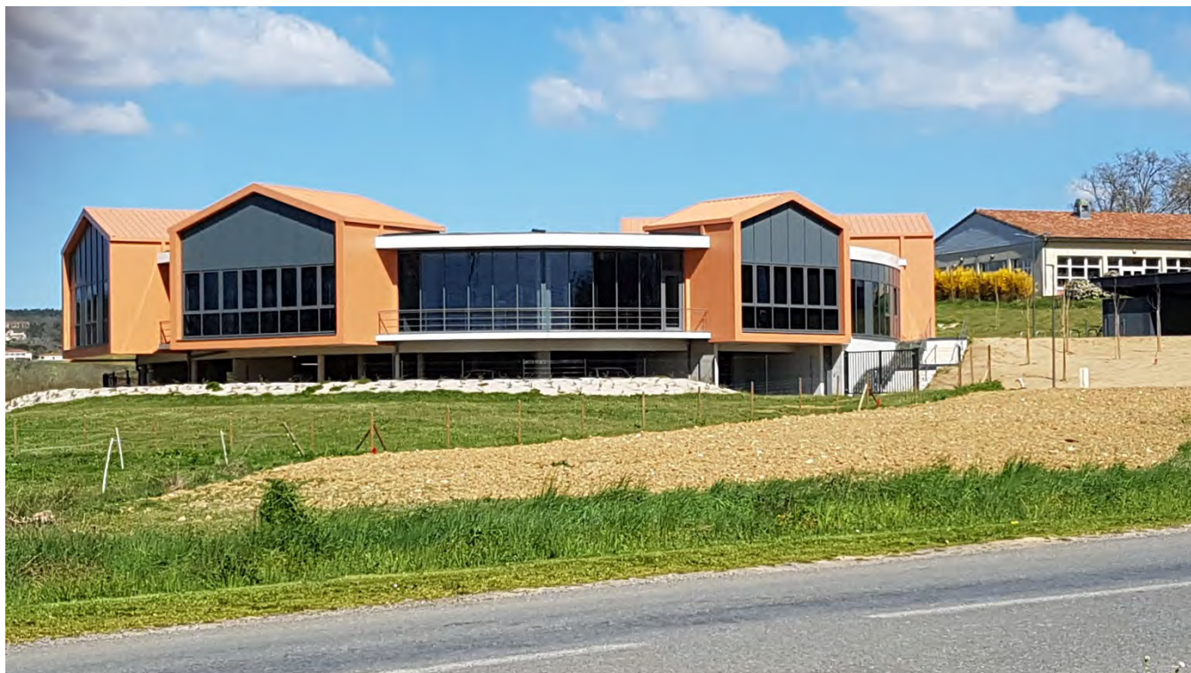
Figure 1 : Vue d'ensemble du bâtiment de Maison du Campus
