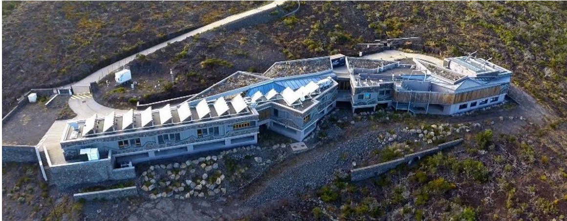
Figure 5 : vue façade ouest
