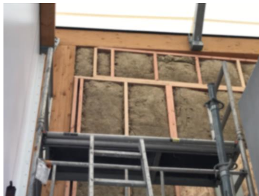
Figure 21 : façade extérieure en phase de chantier
