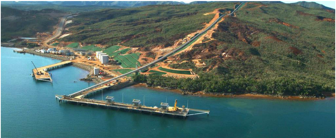
Figure 2 : Installations portuaires de Vale dans le sud de la Nouvelle-Calédonie (source : www.vale.nc )
