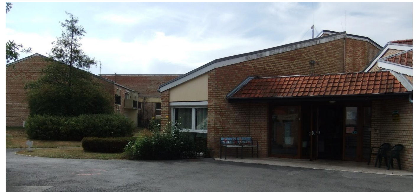
ENTRÉE DU FPA
