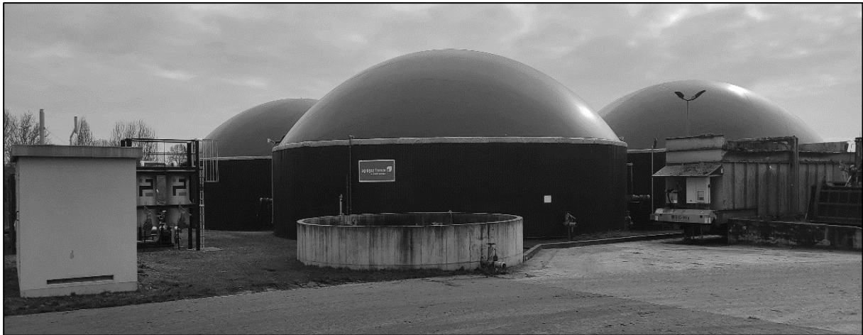
Figure 2 : site de l'unité de méthanisation de Val de Briey (54)
