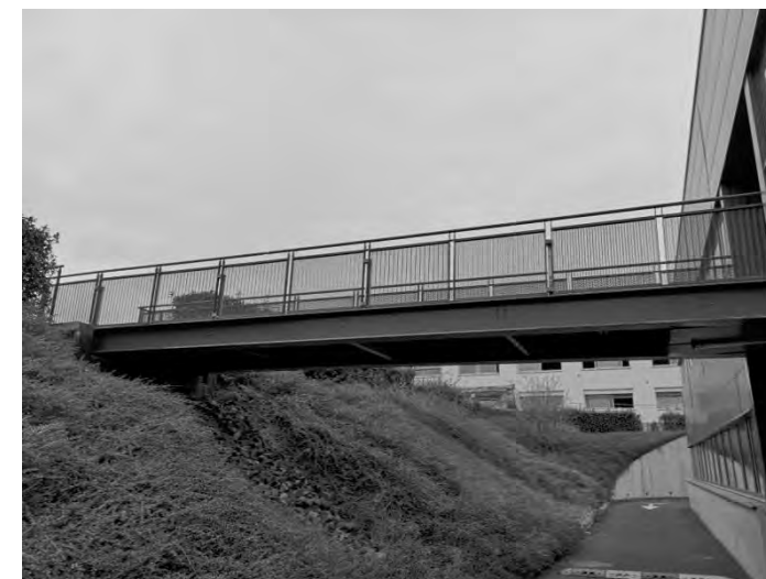
Photo 6 : photo de la passerelle
