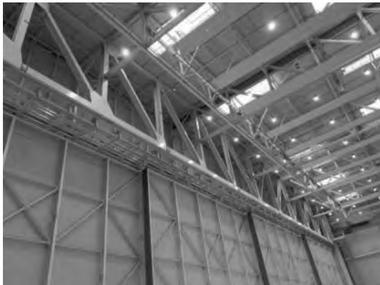
Photo 3 : photo de la poutre treillis au-dessus de la porte d'entrée
