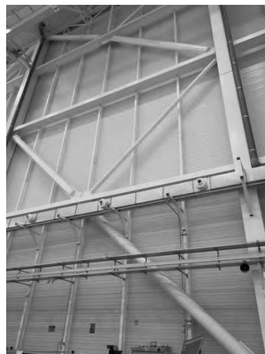
Photo 5 : photo d'un système de contreventement latéral
