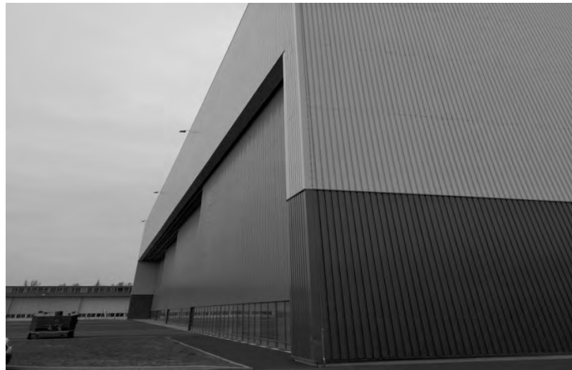
Photo 1 : photo du hangar de maintenance (porte d'entrée)
