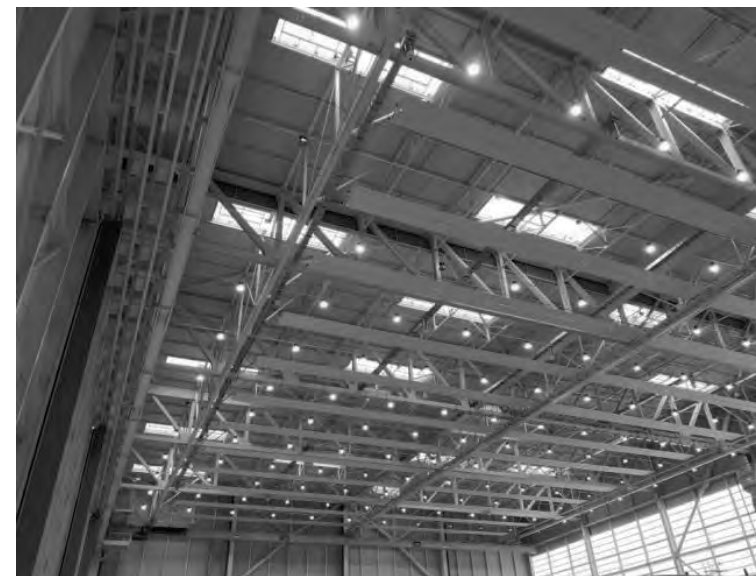
Photo 4 : photo du réseau de poutres-treillis (charpente métallique)
