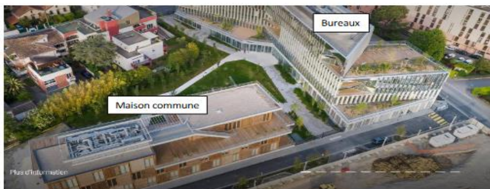
Figure 1 : Vue aérienne du projet
