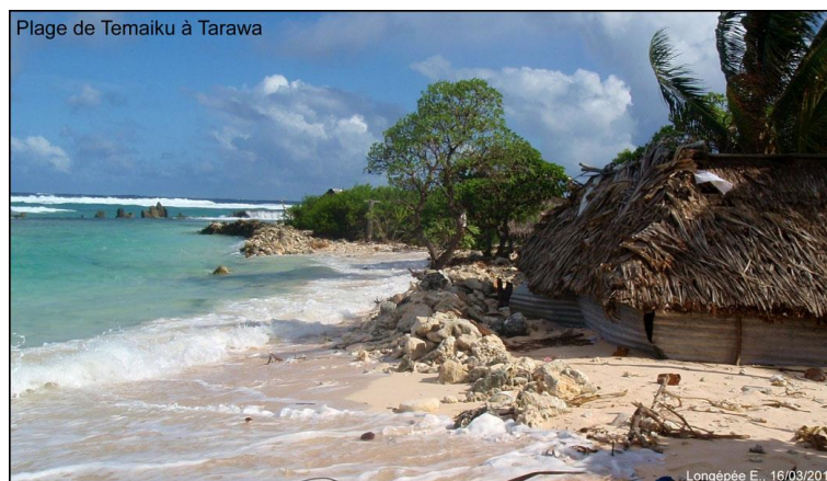
Maisons en haut de plage régulièrement soumises à des submersions à Temaiku.
