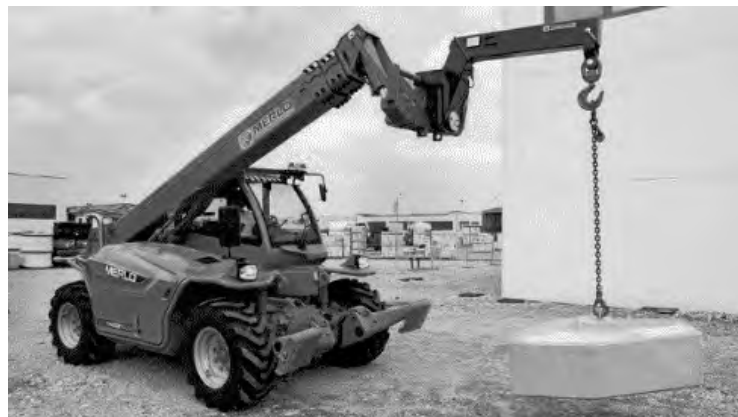
Figure 13 : Grue a pneu.
