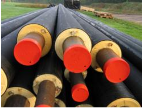
Figures 7 : Tubes et pose en tranchée
