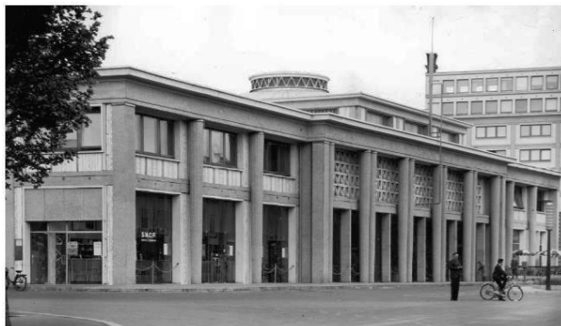
Ancienne gare routière Façade Nord (1960)
