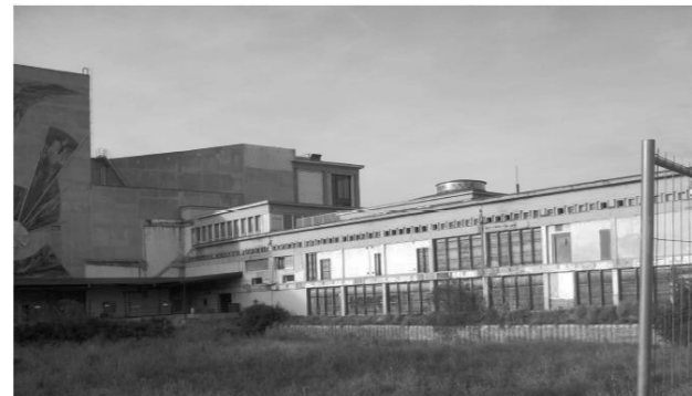
Ancienne gare routière Façade Sud avant travaux
