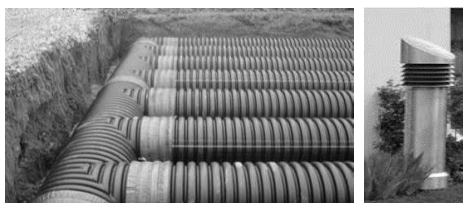
Figure 4 : Puits thermiques – Prise d'air extérieur
