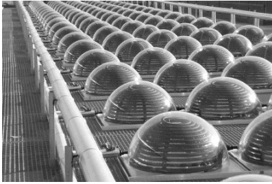
Figure 6 : Capteurs solaires dômes en toiture
