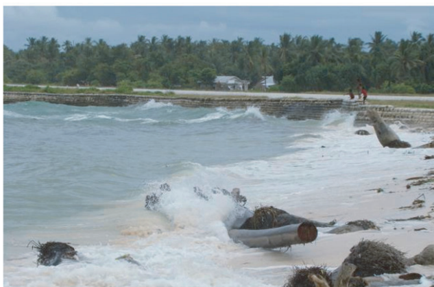
E. Côte océanique de Bonriki (Tarawa Sud, Kiribati), au droit de la piste d'atterrissage : l'érosion n'est pas contenue par le mur de protection édifié par les autorités (cliché : V. Duvat, 2010).
