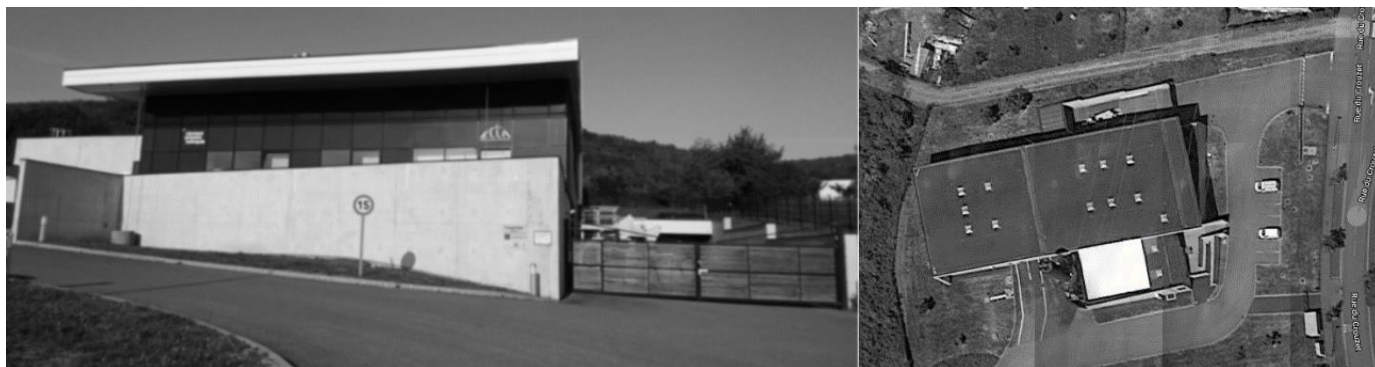
Figure 4 : La chaufferie ECLA du quartier de la Croix-de-Neyrat (Source Google Maps Sat)
