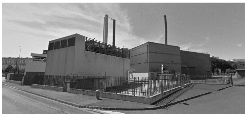
Figure 6 : Chaufferie CLERVIA du quartier de la Gauthière (Source Google Maps)
