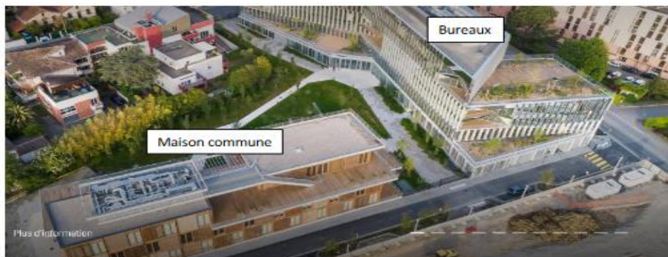
Figure 1 : Vue aérienne du projet
