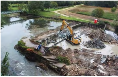
Document 8a : destruction d'un barrage
