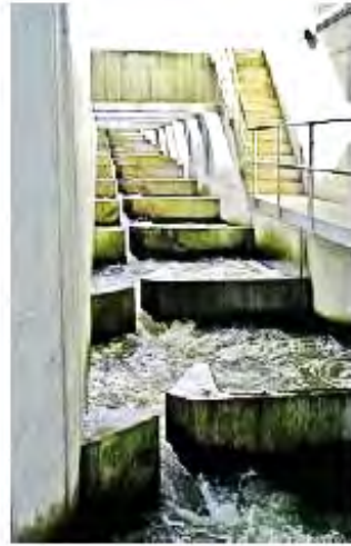
Document 8c : passe à poissons de type barrages successifs pour saumon
