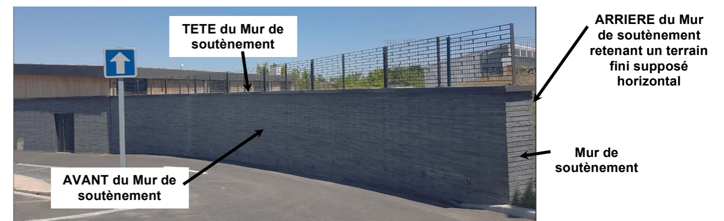
Figure 6 : photo du mur de soutènement
