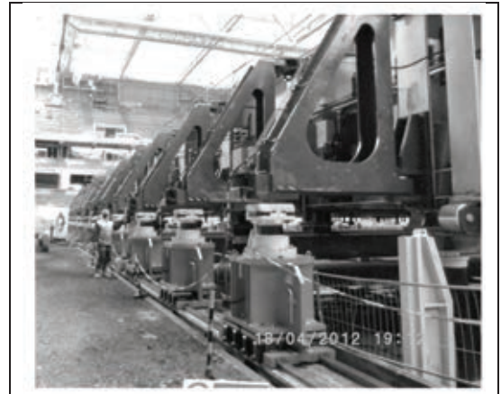
Figure 6 : plateau en cours de translation sur les chariots rouleurs
